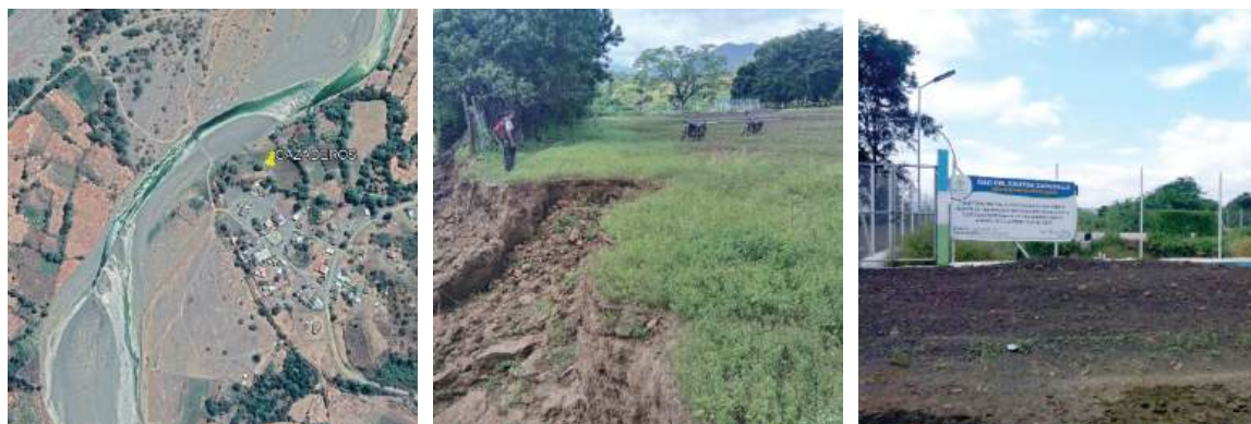
Figura 32. Afectaciones de Planta de aguas residuales por inundaciones en la parroquia Cazaderos
