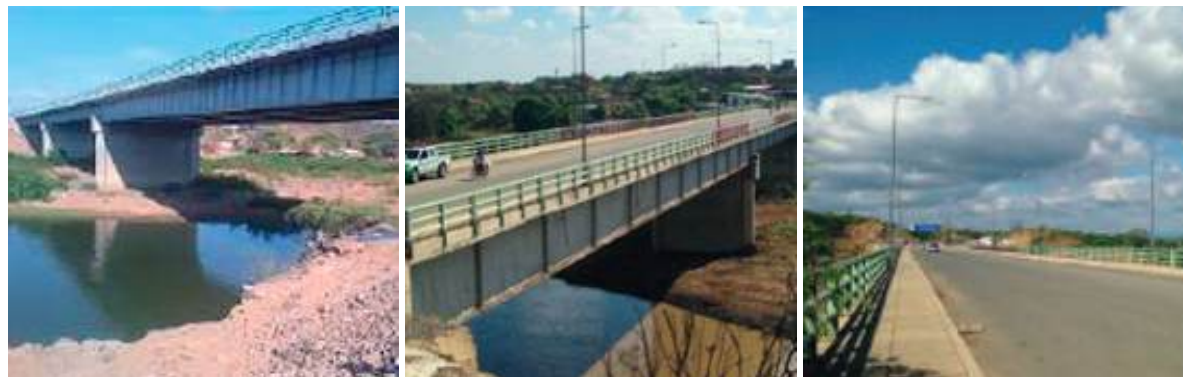
Figura 31. Infraestructura Puente Internacional Lalamor Ecuador-Perú
